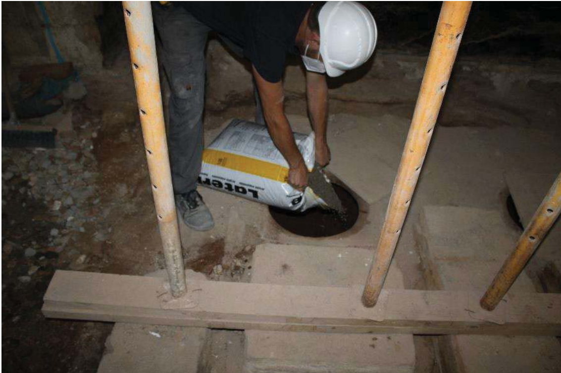
Reble de les tines amb sauló i argila expandida.
