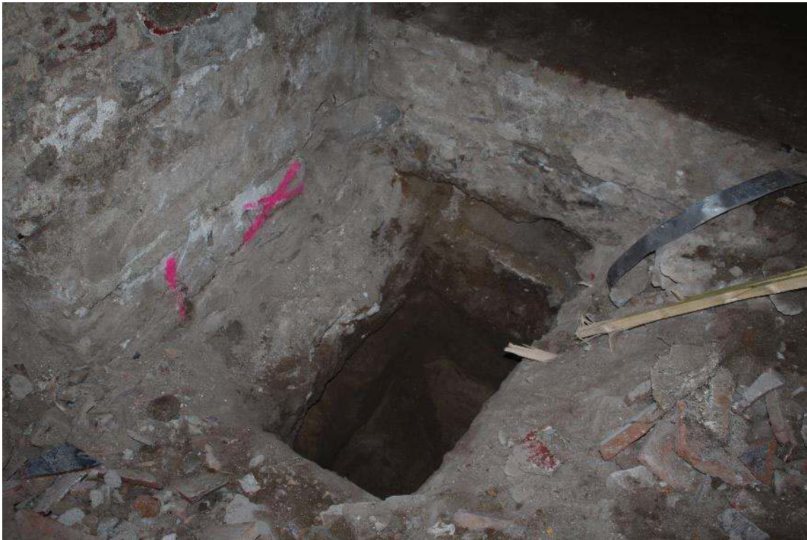
Pou 8 amb els nivells on és visible el nivell de sorres netes al fons.
