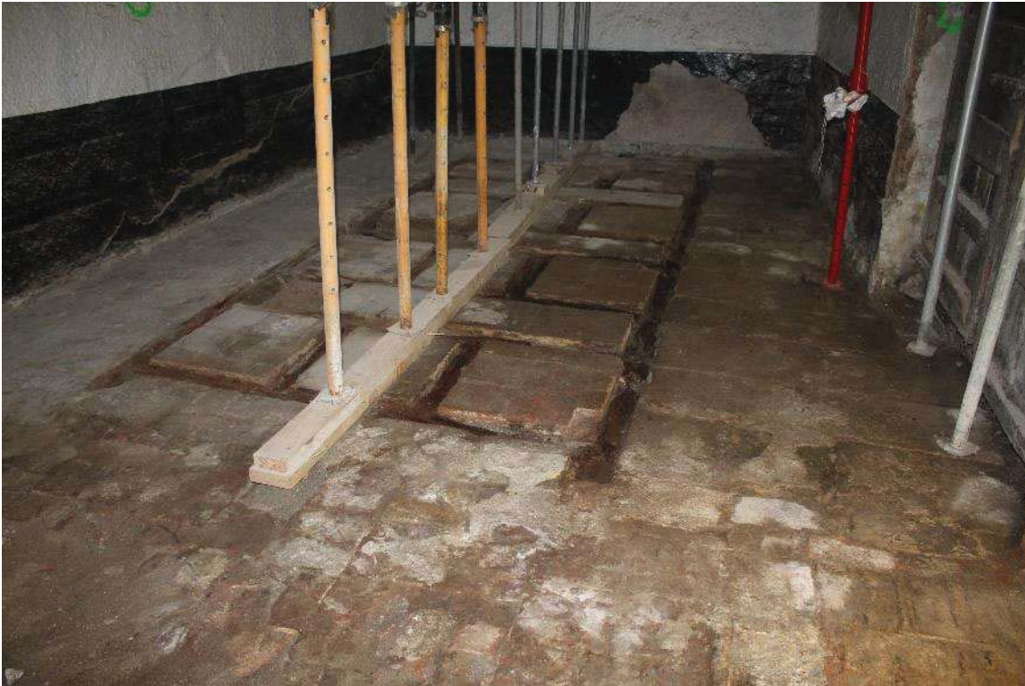
Paviment UE 1000 amb les estructures de ceràmica i tramat de fustes.
