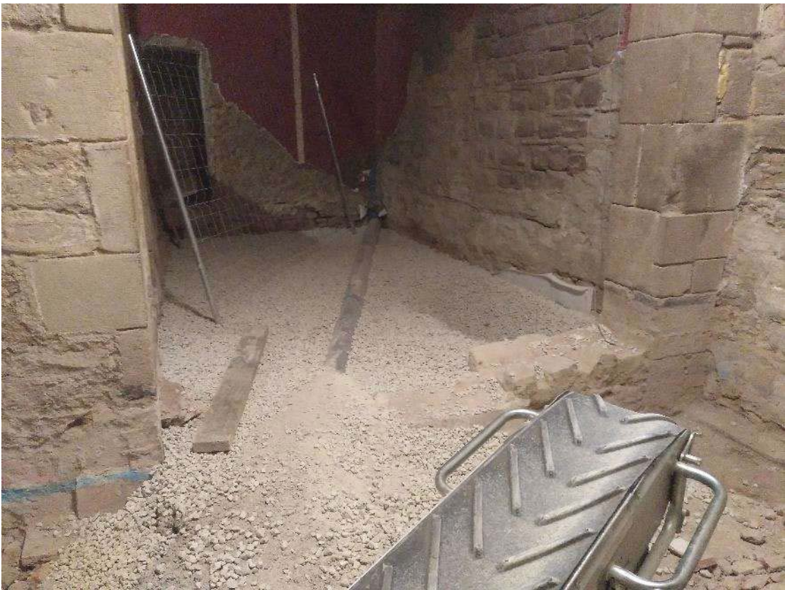
Acabat de graves com a base de la nova pavimentació.
