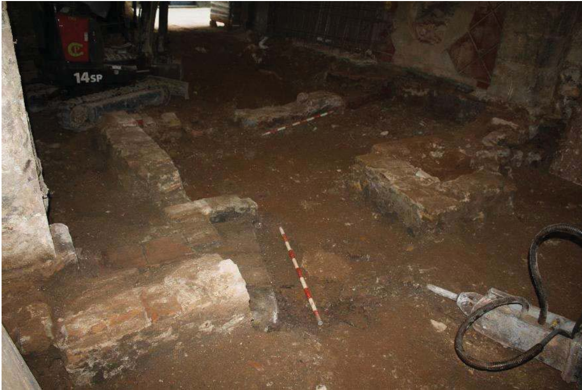
Vista del semisoterrani localitzat en el local 4.
