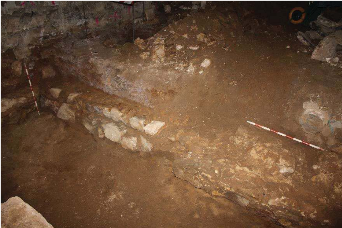
Vista general de la fonamentació UE 219.
