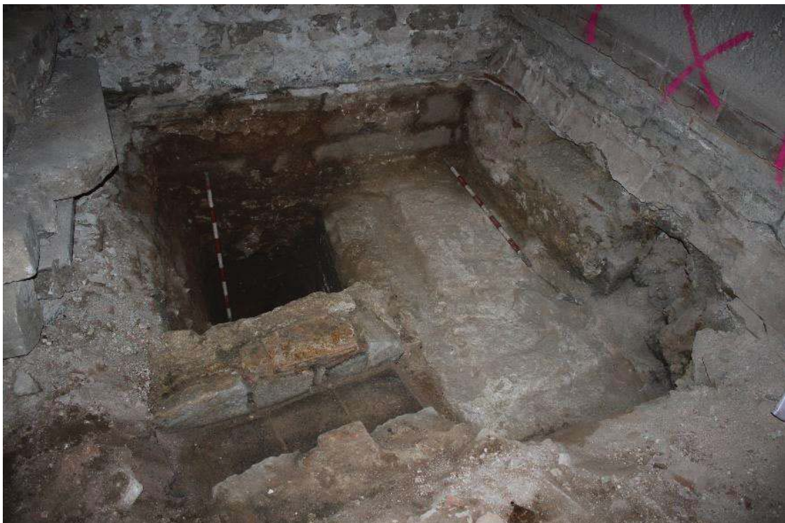
Vista de l'encofrat conservat a la cara de ponent de la UE 404, superior, i inferior vista del tram UE 338
