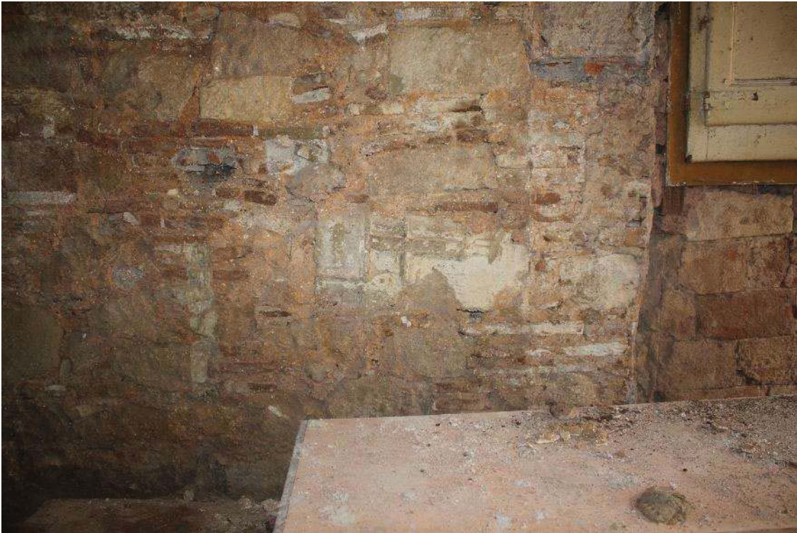
Fragment de finestra gòtica aprofitat en el parament de l'obra.
